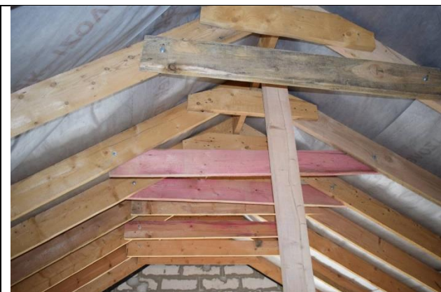
Фото43 Кровля. Стропильная система (вид1)
