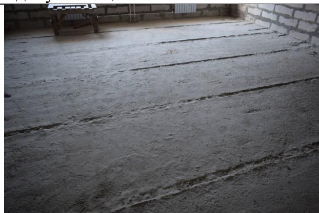
Фото24 Межэтажное перекрытие на отм.0.000 (вид2)
