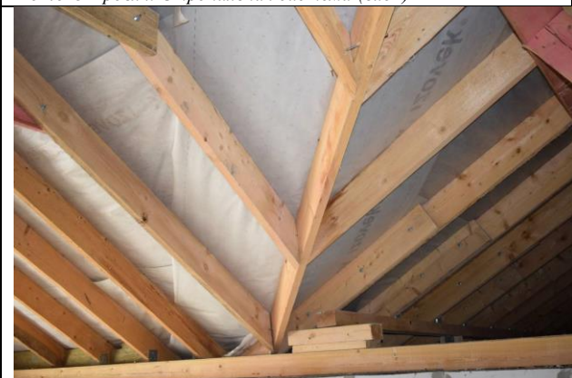
Фото45 Кровля. Стропильная система (вид3)
