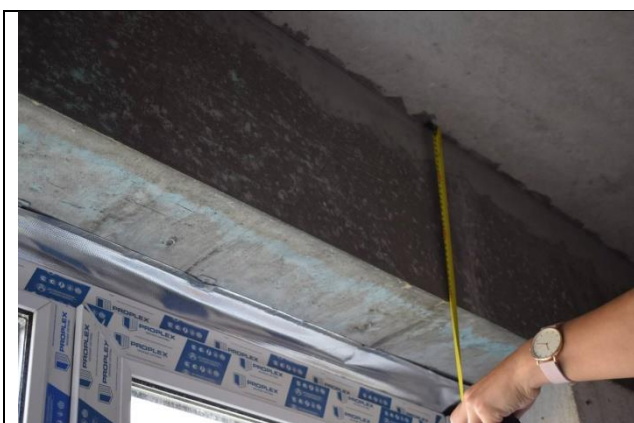
Фото35 Монолитный пояс на отметке +2.750 (вид1)
