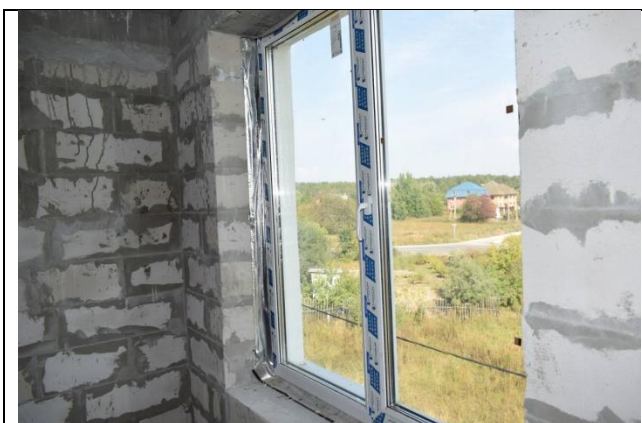
Фото61 Обследование окон (вид 1)
