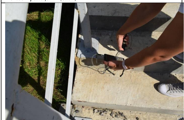
Фото55 Крыльцо К1. Замер прочности бетона (вид1)
