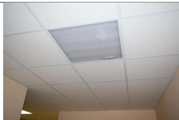
Фото70 Обследование потолка. Тип 1 (вид2)
