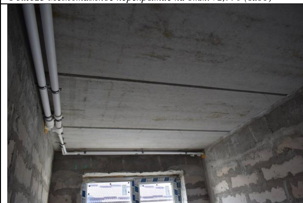
Фото27 Межэтажное перекрытие на отм.+5,940 (вид1)
