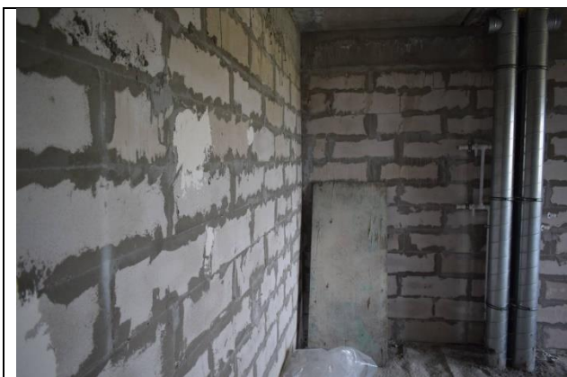
Фото17 Внутренние стены 1 этажа (вид1)
