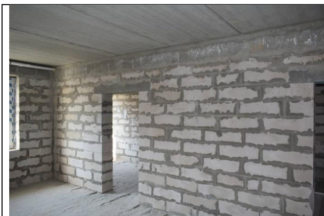
Фото19 Внутренние стены 1 этажа (вид3)
