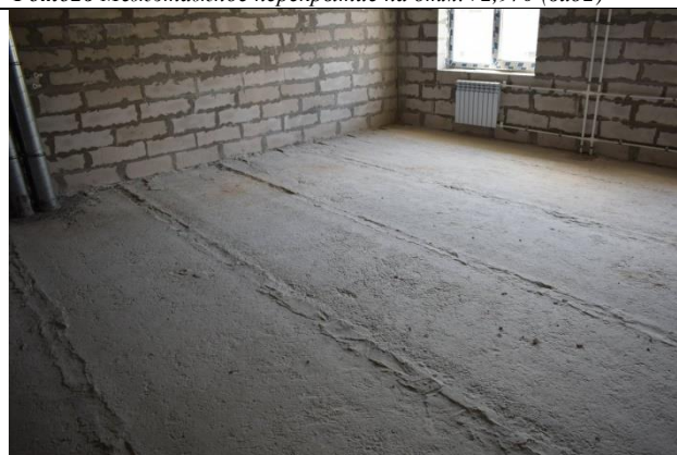
Фото28 Межэтажное перекрытие на отм.+5,940 (вид2)
