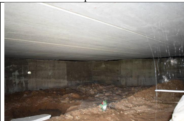
Фото23 Межэтажное перекрытие на отм.0.000 (вид1)
