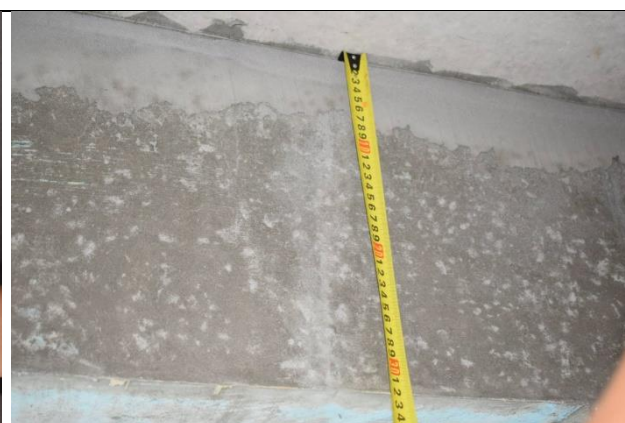
Фото36 Монолитный пояс на отметке +2.750 (вид2)
