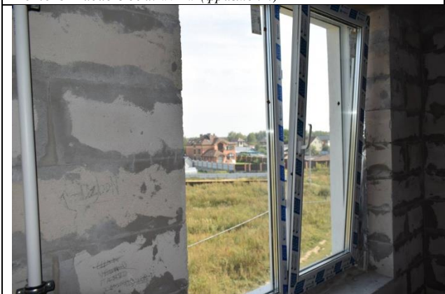
Фото15 Фасад в осях «Г-А» (фрагмент)
