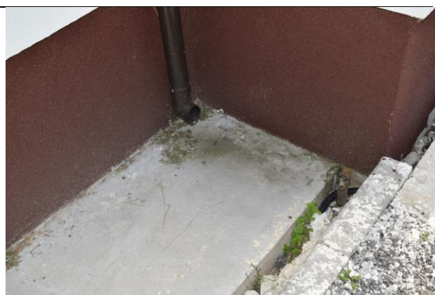
Фото58 Обследование отмостки (вид2)
