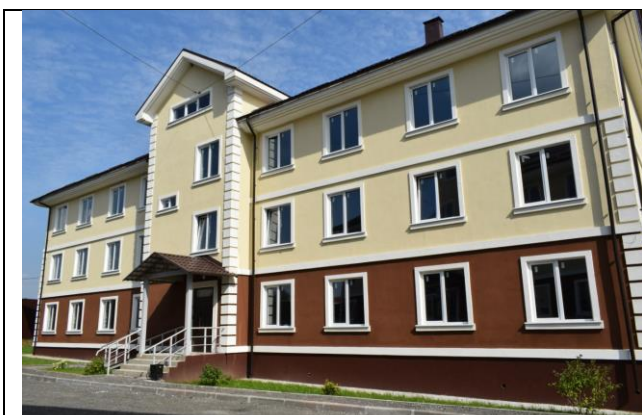
Фото09 Фасад в осях «1-6» (вид1)
