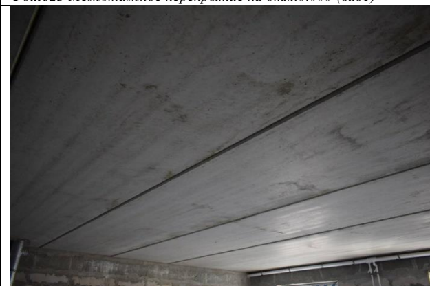
Фото25 Межэтажное перекрытие на отм.+2,970 (вид1)
