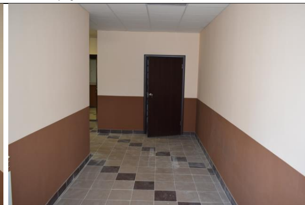
Фото22 Внутренние стены 3 этажа (вид1)
