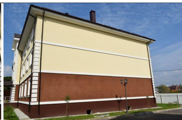
Фото10 Фасад в осях «А-Г» (вид1)
