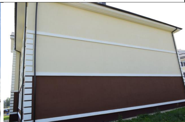
Фото12 Фасад в осях «Г-А» (вид1)
