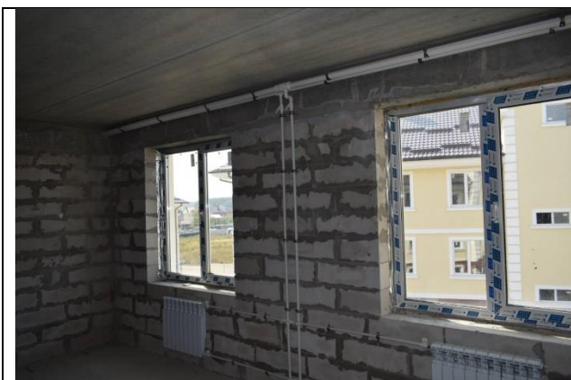
Фото13 Фасад в осях «Б-1» (фрагмент)
