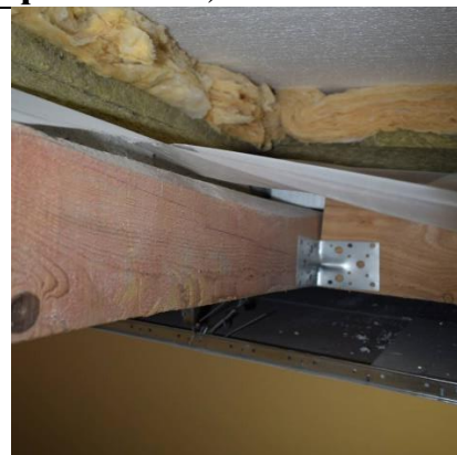
Фото34 Межэтажное перекрытие на отм. +8,910 (вид2)
