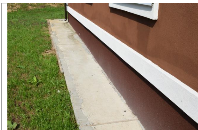
Фото57 Обследование отмостки (вид1)
