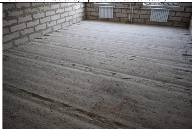
Фото26 Межэтажное перекрытие на отм.+2,970 (вид2)
