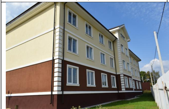
Фото11 Фасад в осях «6-1» (вид1)
