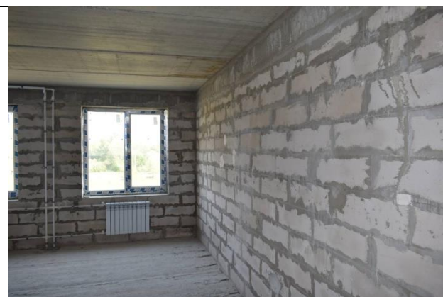
Фото18 Внутренние стены 1 этажа (вид2)
