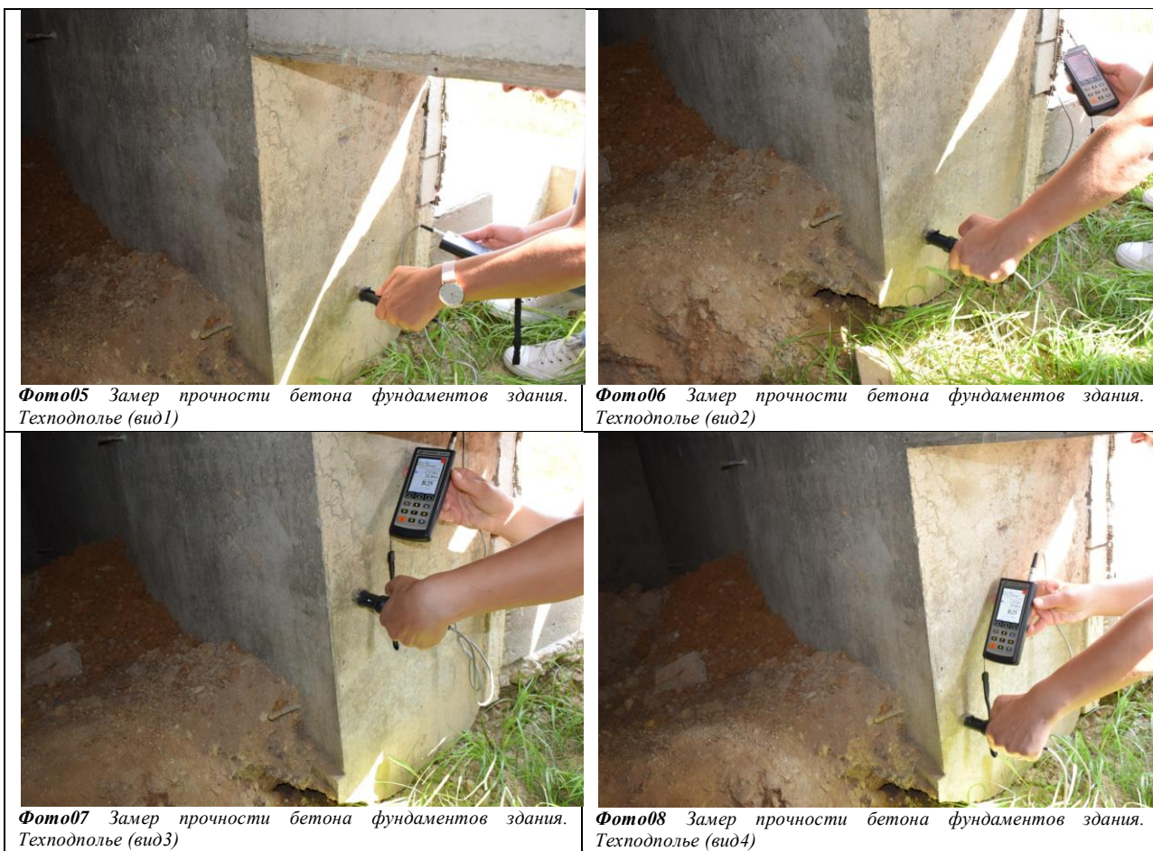
Фото05-08 Замер прочности бетона фундаментов здания. Техподполье
