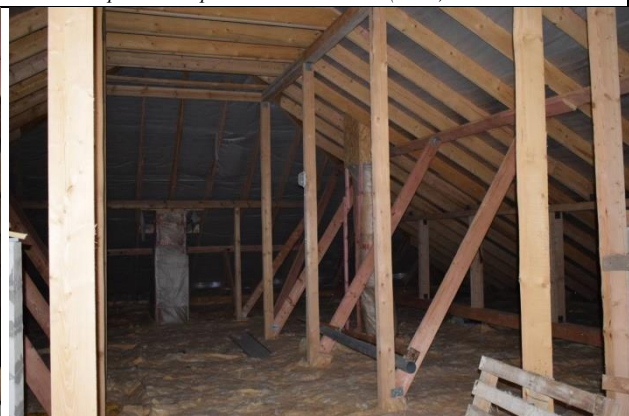
Фото46 Кровля. Стропильная система (вид4)
