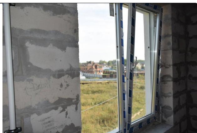
Фото62 Обследование окон (вид 2)
