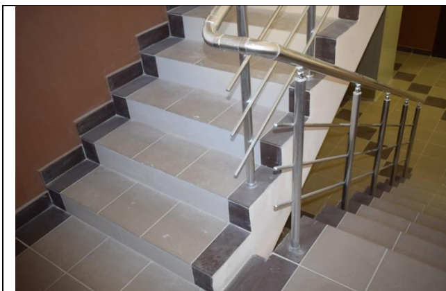
Фото39 Лестница Л1 (вид1)
