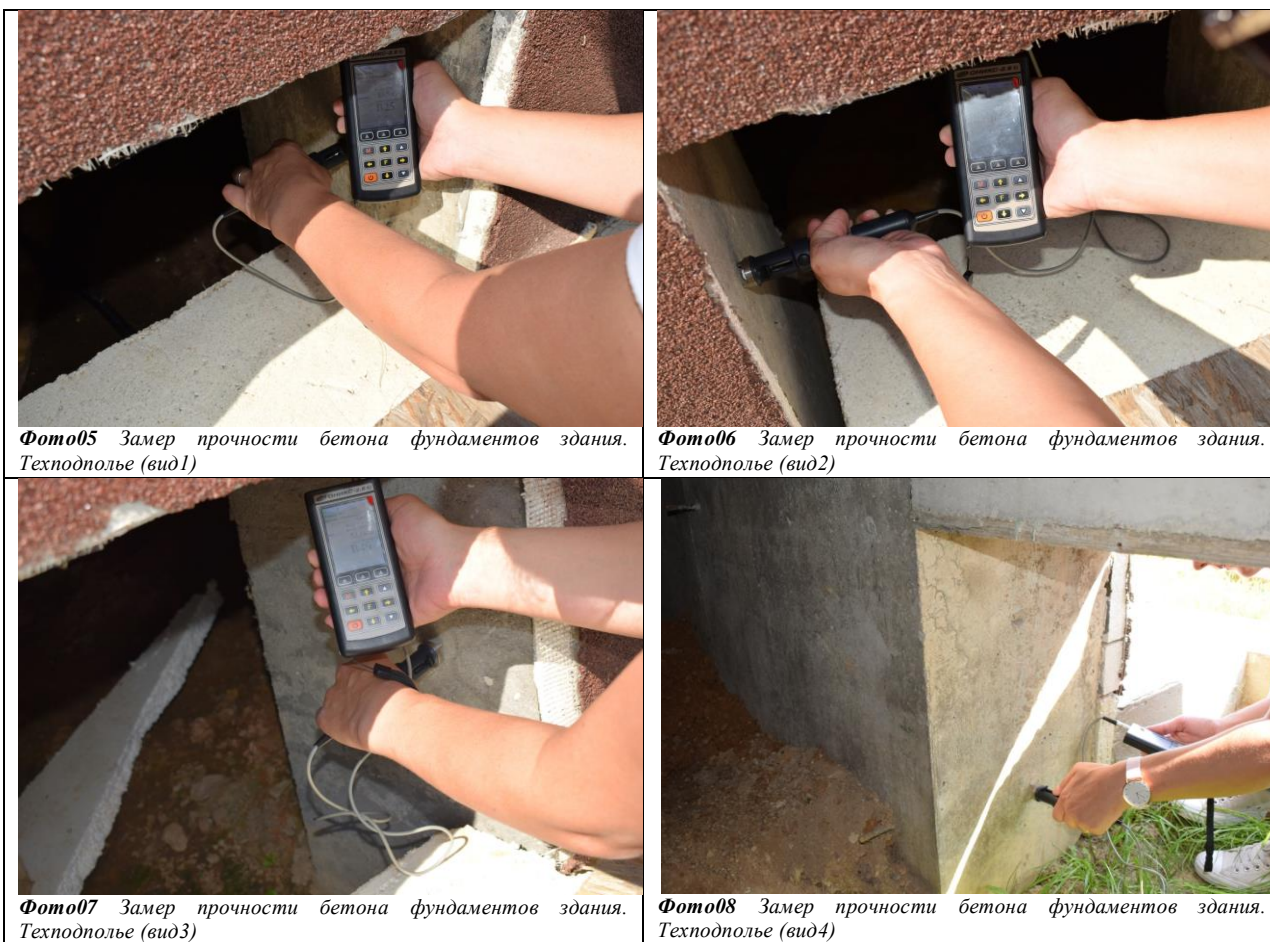
Фото05-08 Замер прочности бетона фундаментов здания. Техподполье
