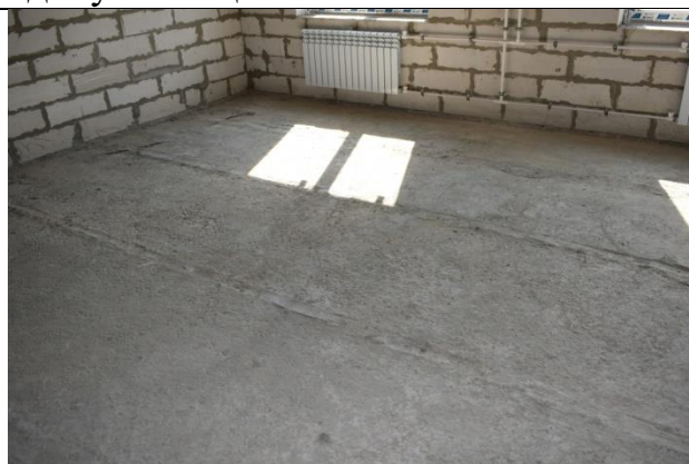
Фото24 Межэтажное перекрытие на отм.0.000 (вид2)
