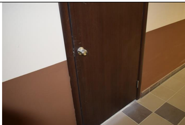
Фото64 Обследование внутренних дверей (вид2)
