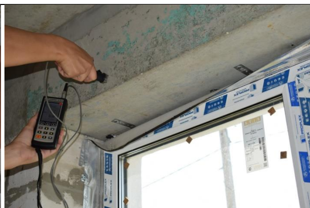
Фото36 Монолитный пояс на отметке +2.750 (вид2)
