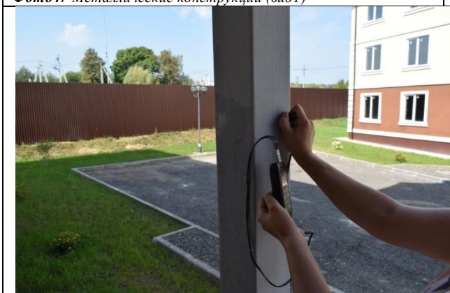
Фото49 Металлические конструкции (вид3)
