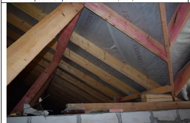
Фото45 Кровля. Стропильная система (вид3)
