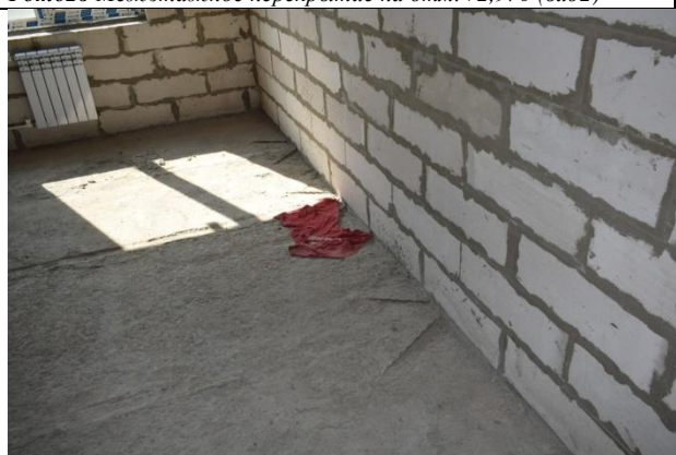
Фото28 Межэтажное перекрытие на отм.+5,940 (вид2)
