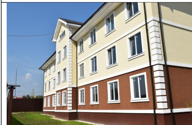
Фото11 Фасад в осях «6-1» (вид1)
