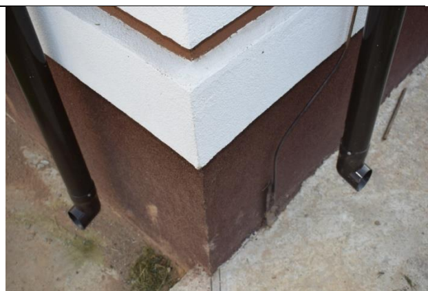
Фото60 Обследование отмостки (вид4)
