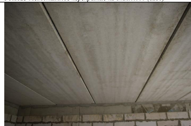
Фото25 Межэтажное перекрытие на отм.+2,970 (вид1)
