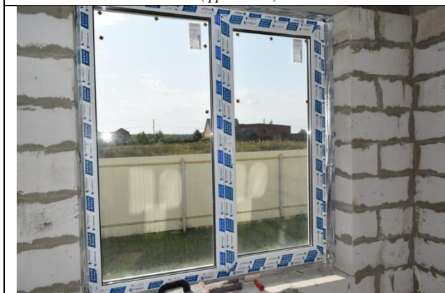
Фото15 Фасад в осях «Г-А» (фрагмент)
