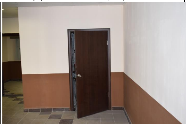
Фото22 Внутренние стены 3 этажа (вид1)
