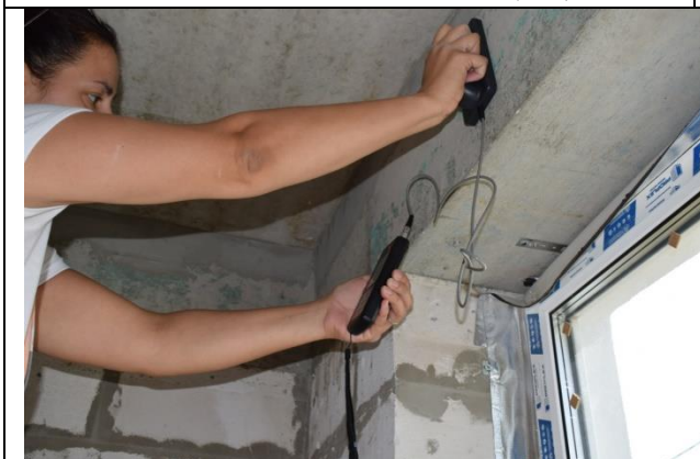
Фото37 Монолитный пояс на отметке +2.750. Определение шага и диаметра арматуры (вид1)
