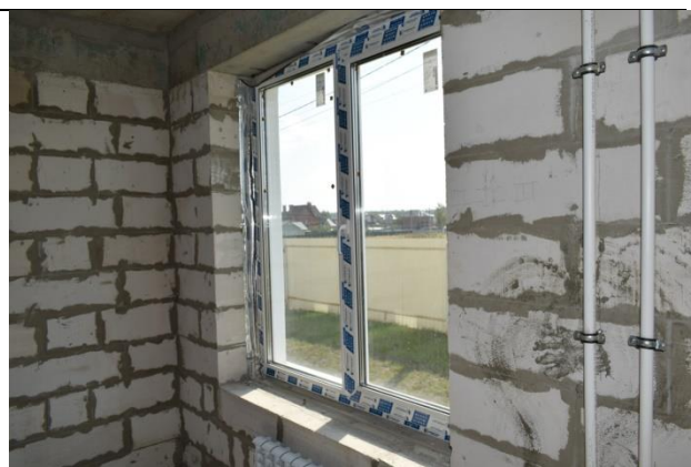
Фото14 Фасад в осях «1-6» (фрагмент)
