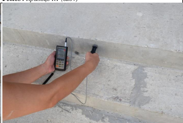
Фото56 Крыльцо К1. Замер прочности бетона (вид2)
