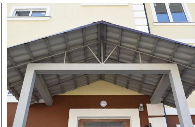
Фото47 Металлические конструкции (вид1)
