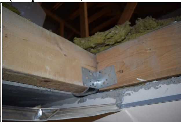
Фото34 Межэтажное перекрытие на отм. +8,910 (вид2)
