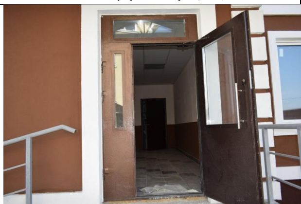
Фото66 Наружные двери (вид1)
