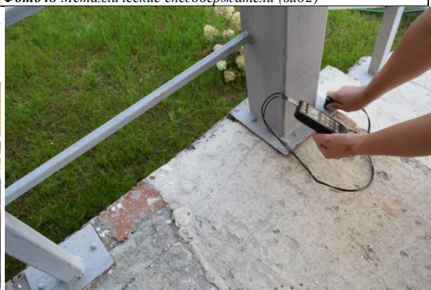
Фото50 Металлические конструкции (вид4)
