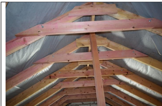
Фото43 Кровля. Стропильная система (вид1)
