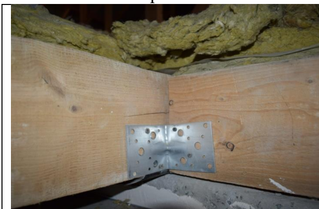
Фото33 Межэтажное перекрытие на отм. +8,910 (вид1)
