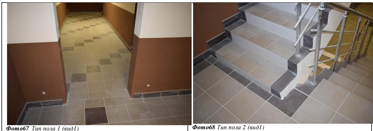
Фото67 Тип пола 1 (вид1)
