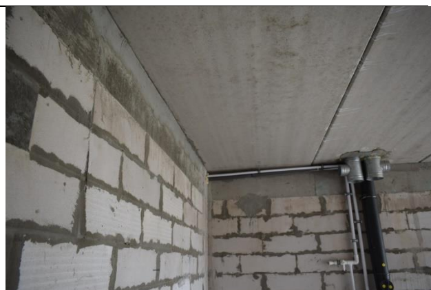
Фото20 Внутренние стены 1 этажа (вид4)
