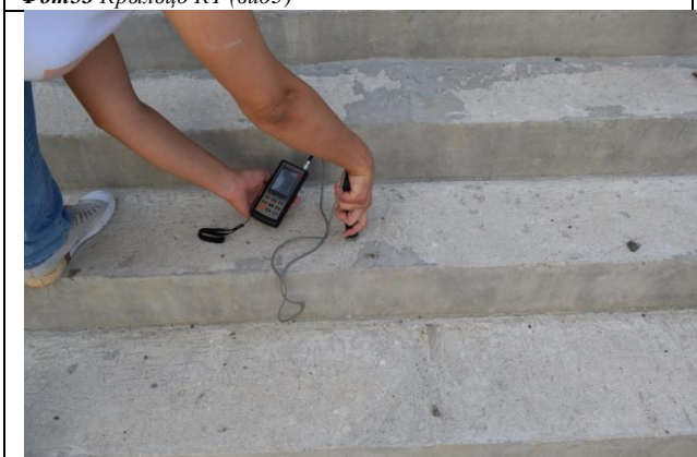
Фото55 Крыльцо К1. Замер прочности бетона (вид1)
