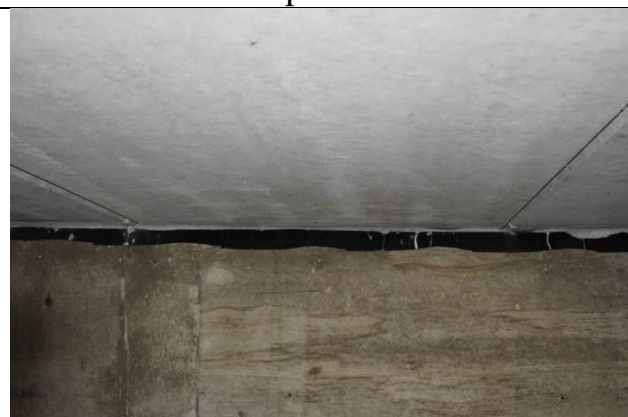
Фото23 Межэтажное перекрытие на отм.0.000 (вид1)
