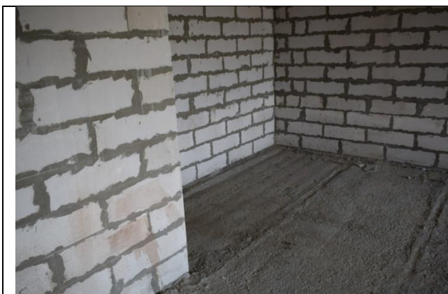
Фото19 Внутренние стены 1 этажа (вид3)
