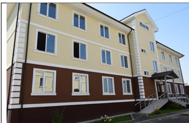
Фото09 Фасад в осях «1-6» (вид1)
