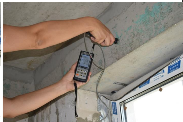
Фото38 Монолитный пояс на отметке +2.750. Замер прочности бетона (вид3)
