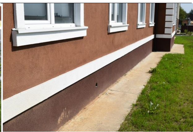
Фото58 Обследование отмостки (вид2)
