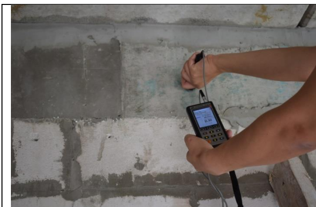
Фото35 Монолитный пояс на отметке +2.750 (вид1)
