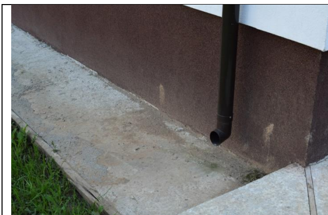
Фото59 Обследование отмостки (вид3)
