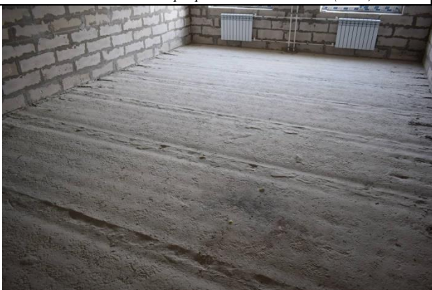
Фото26 Межэтажное перекрытие на отм.+2,970 (вид2)
