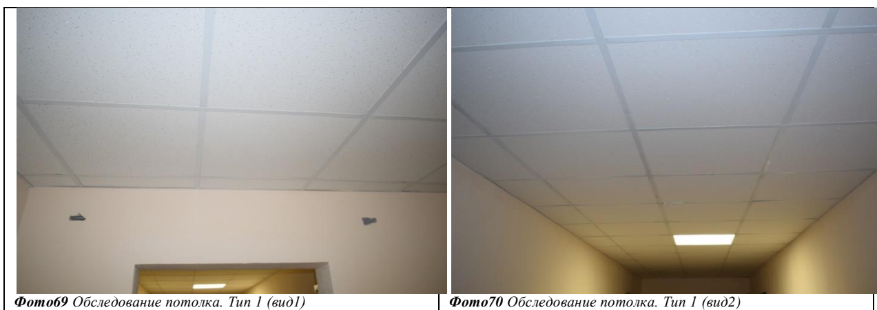
Фото69 Обследование потолка. Тип 1 (вид1)
