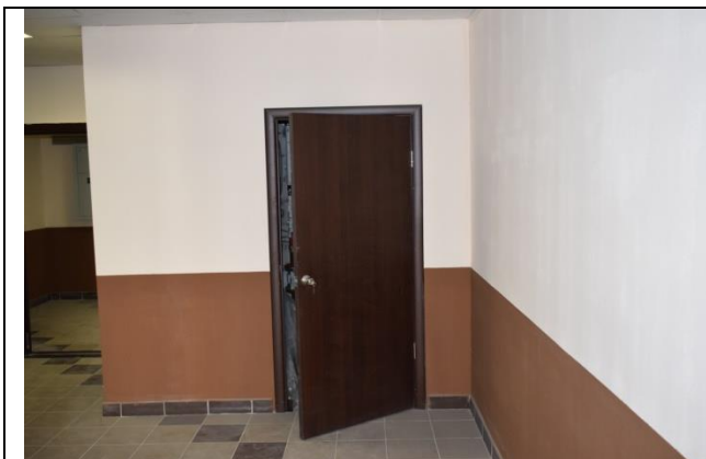
Фото63 Обследование внутренних дверей (вид1)
