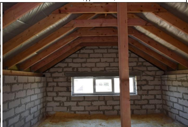
Фото16 Фасад в осях «1-6» (фрагмент)
