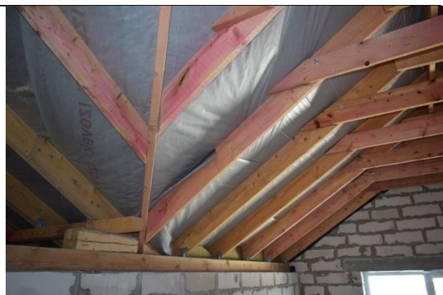
Фото44 Кровля. Стропильная система (вид2)
