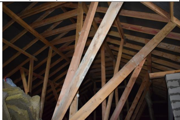
Фото46 Кровля. Стропильная система (вид4)
