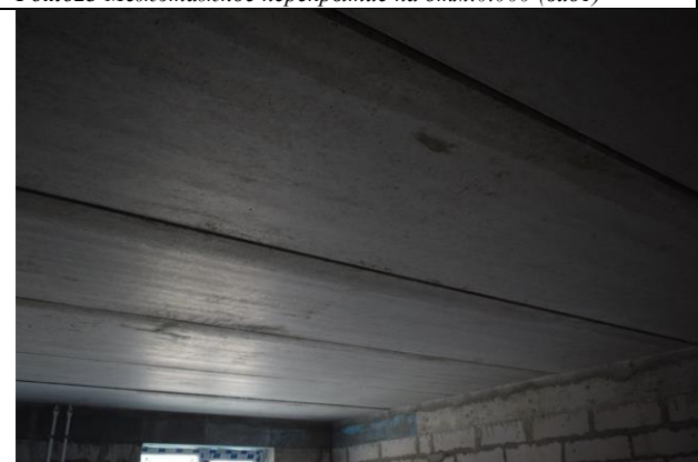
Фото25 Межэтажное перекрытие на отм.+2,970 (вид1)
