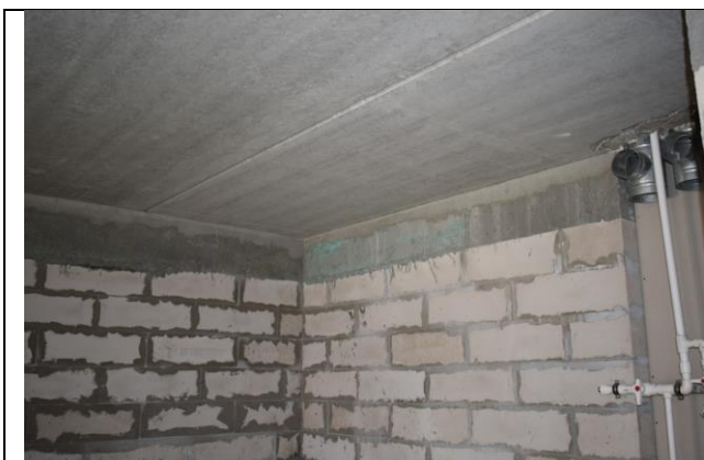
Фото17 Внутренние стены 1 этажа (вид1)
