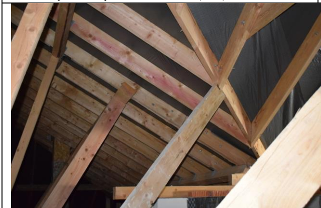
Фото45 Кровля. Стропильная система (вид3)
