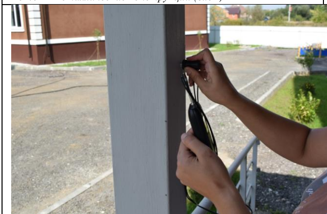
Фото49 Металлические конструкции (вид3)
