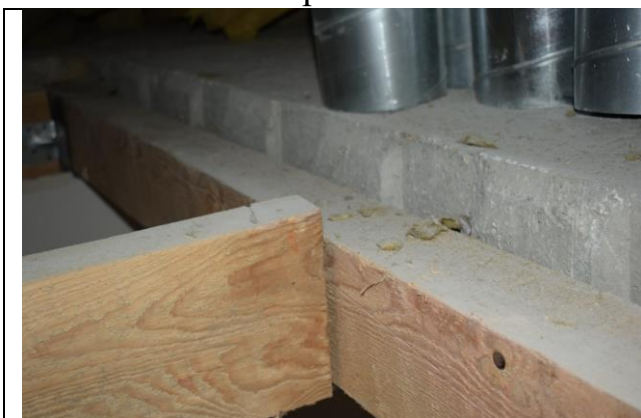
Фото 33 Межэтажное перекрытие на отм. +8,910 (вид 1)
