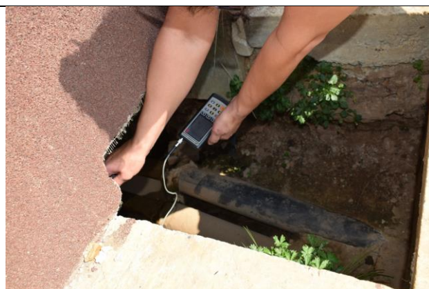
Фото06 Замер прочности бетона фундаментов здания. Техподполье (вид2)
