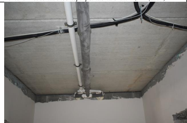
Фото27 Межэтажное перекрытие на отм.+5,940 (вид1)
