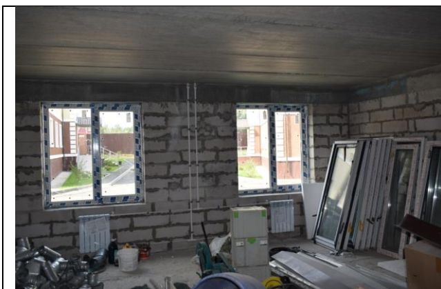
Фото13 Фасад в осях «б-1» (фрагмент)
