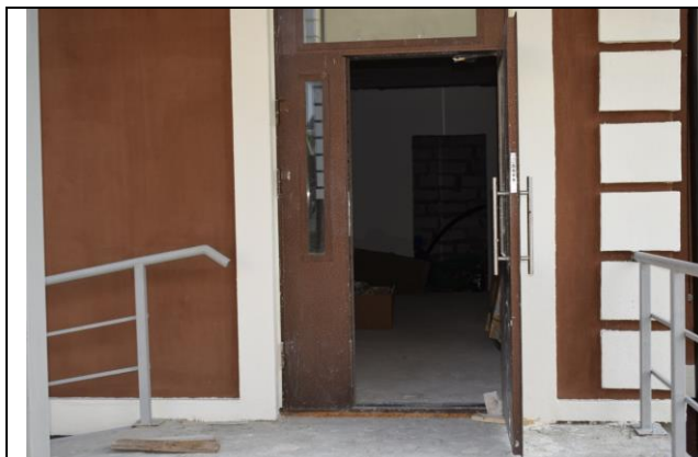
Фото63 Обследование внутренних дверей (вид1)
