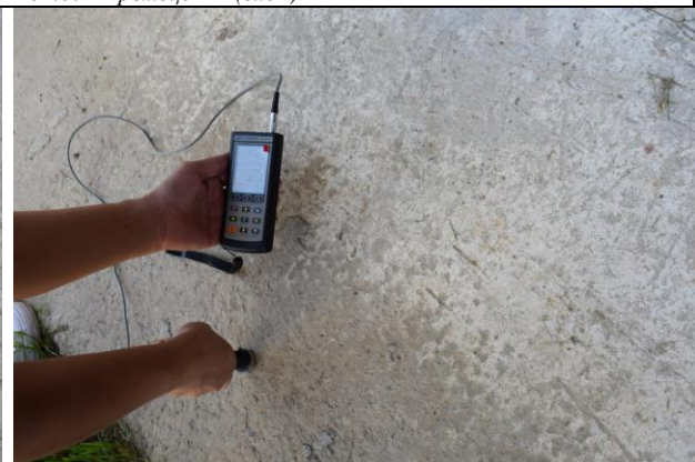
Фото56 Крыльцо К1. Замер прочности бетона (вид2)
