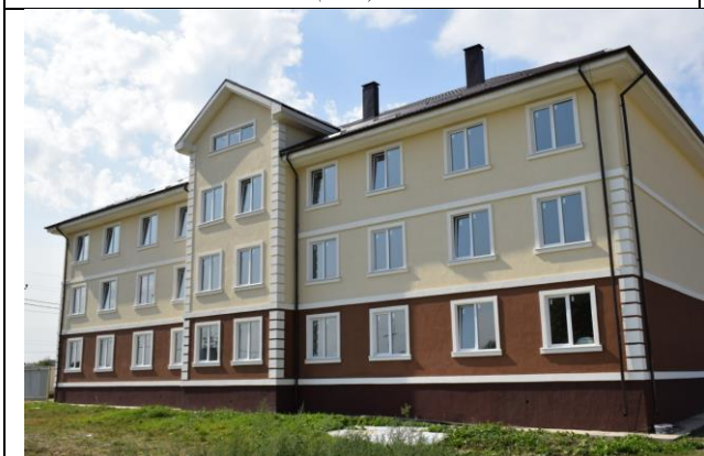
Фото11 Фасад в осях «6-1» (вид1)
