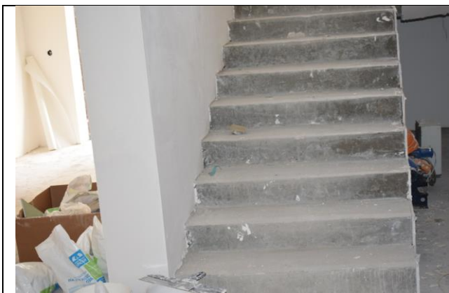
Фото39 Лестница Л1 (вид1)
