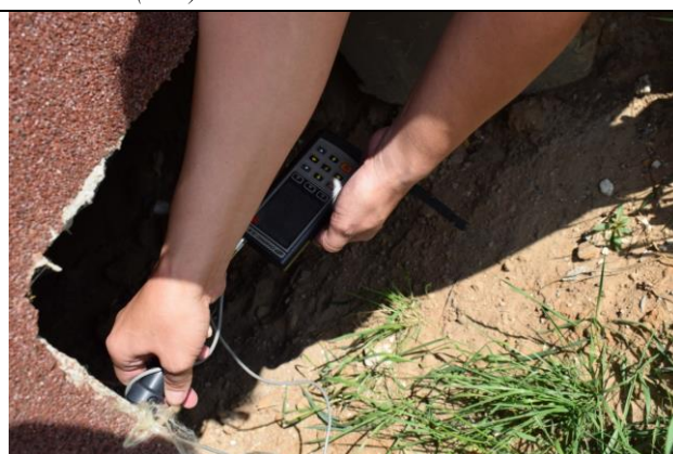
Фото08 Замер прочности бетона фундаментов здания. Техподполье (вид4)
