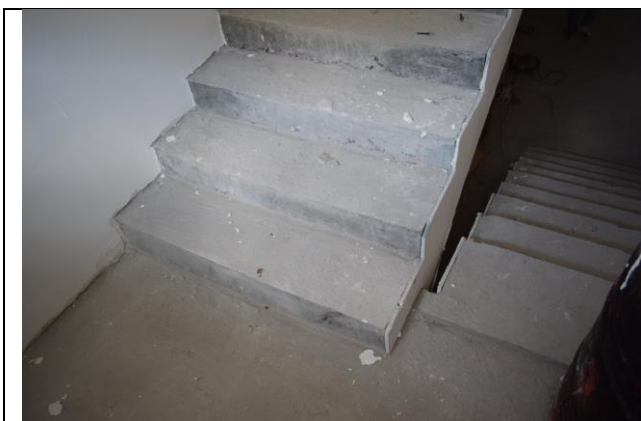
Фото41 Лестница Л1 (вид3)
