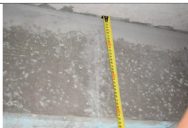
Фото36 Монолитный пояс на отметке +2.750 (вид2)
