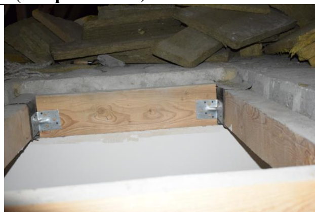
Фото 34 Межэтажное перекрытие на отм. +8,910 (вид 2)
