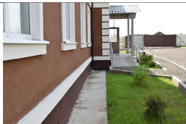
Фото60 Обследование отмостки (вид4)
