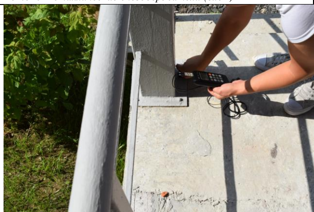
Фото50 Металлические конструкции (вид4)
