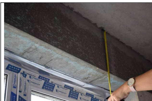
Фото35 Монолитный пояс на отметке +2.750 (вид1)
