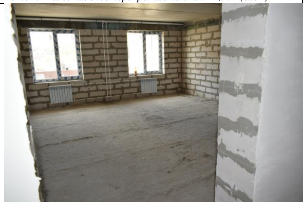
Фото28 Межэтажное перекрытие на отм.+5,940 (вид2)
