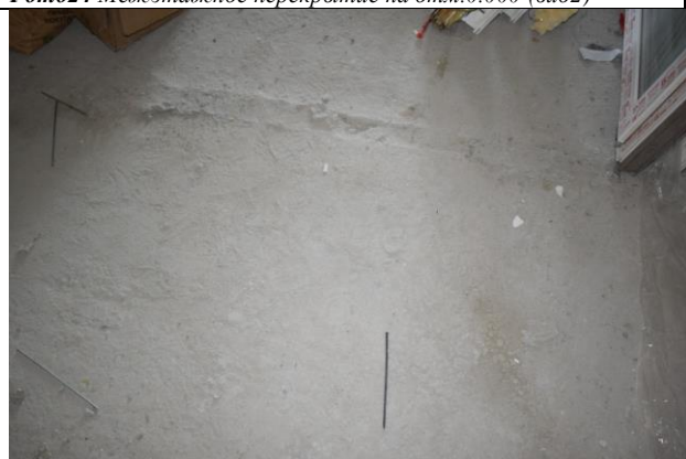
Фото26 Межэтажное перекрытие на отм.+2,970 (вид2)
