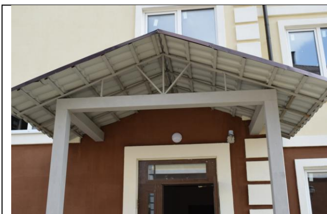
Фото47 Металлические конструкции (вид1)
