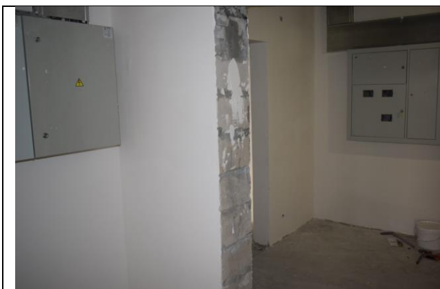
Фото19 Внутренние стены 1 этажа (вид3)
