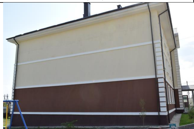
Фото12 Фасад в осях «Г-А» (вид1)
