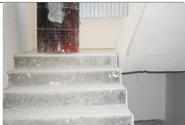
Фото40 Лестница Л1 (вид2)
