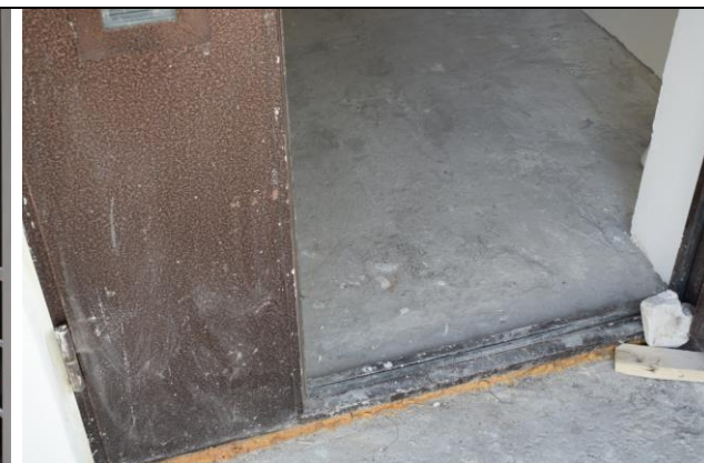
Фото64 Обследование внутренних дверей (вид2)
