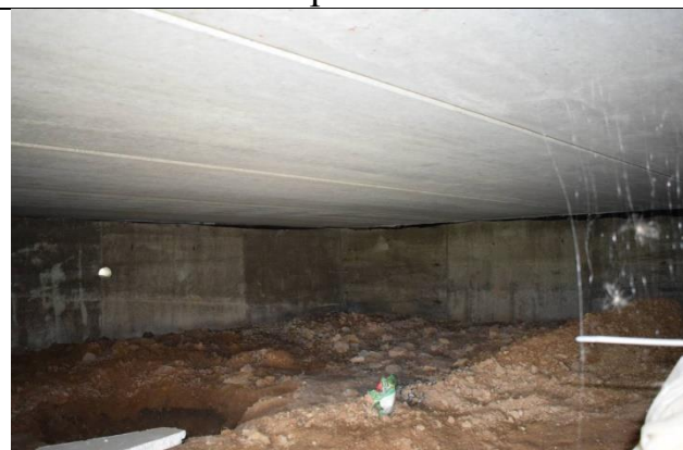
Фото23 Межэтажное перекрытие на отм.0.000 (вид1)
