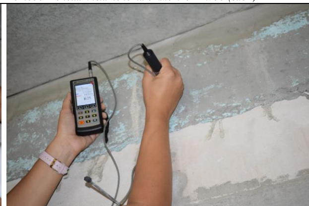
Фото38 Монолитный пояс на отметке +2.750. Замер прочности бетона (вид2)
