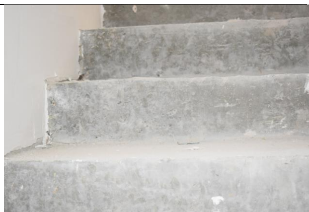
Фото42 Лестница Л1 (вид4)
