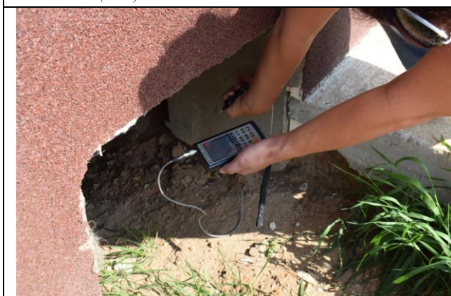
Фото07 Замер прочности бетона фундаментов здания. Техподполье (вид3)
