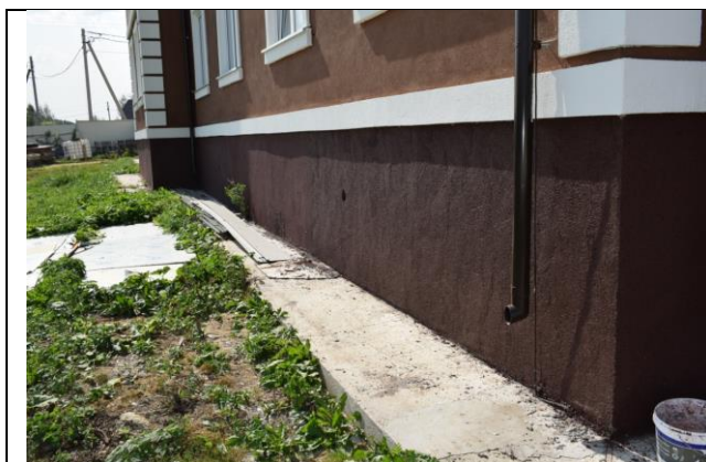
Фото57 Обследование отмостки (вид1)
