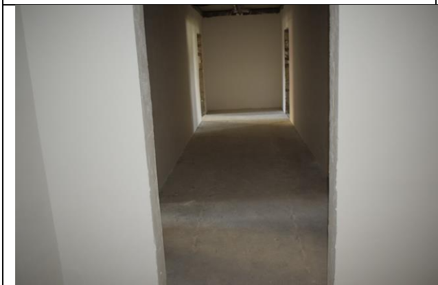
Фото21 Внутренние стены 2 этажа (вид1)
