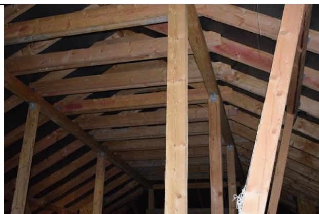
Фото44 Кровля. Стропильная система (вид2)
