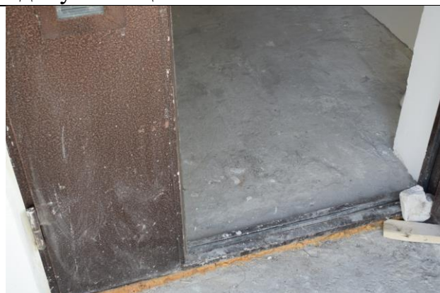
Фото24 Межэтажное перекрытие на отм.0.000 (вид2)
