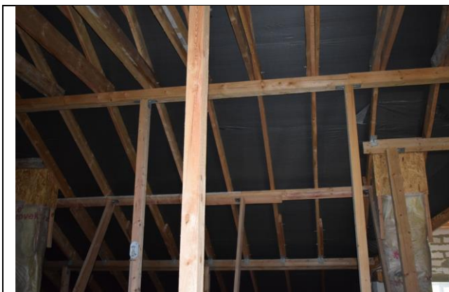
Фото43 Кровля. Стропильная система (вид1)
