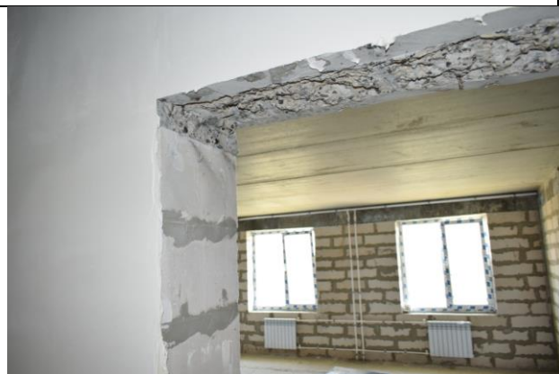
Фото22 Внутренние стены 3 этажа (вид1)
