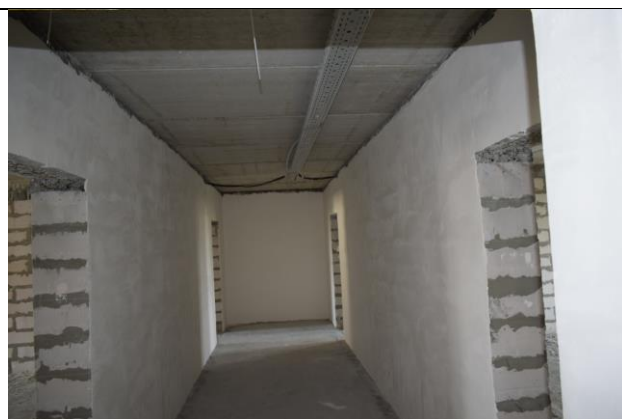
Фото20 Внутренние стены 1 этажа (вид4)
