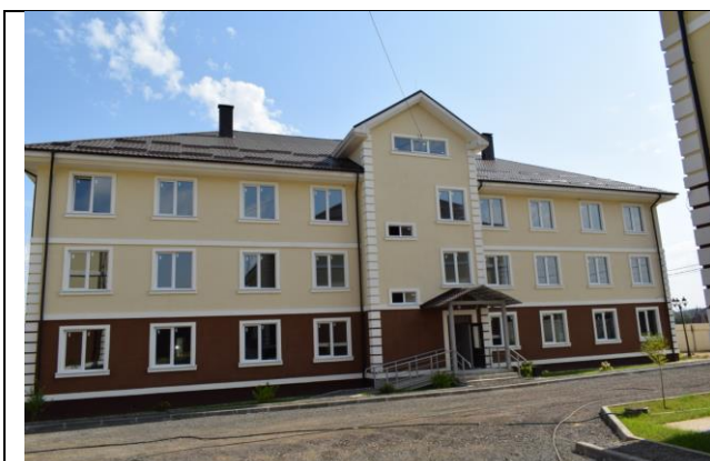
Фото09 Фасад в осях «1-6» (вид1)
