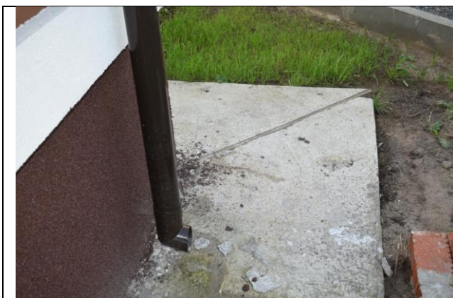
Фото59 Обследование отмостки (вид3)
