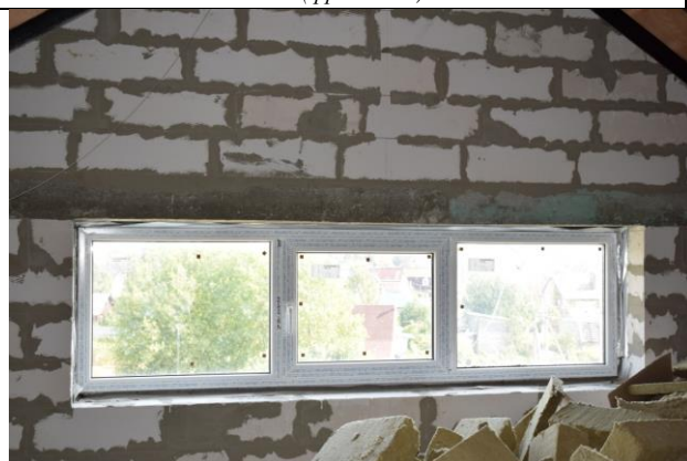
Фото16 Фасад в осях «1-б» (фрагмент)
